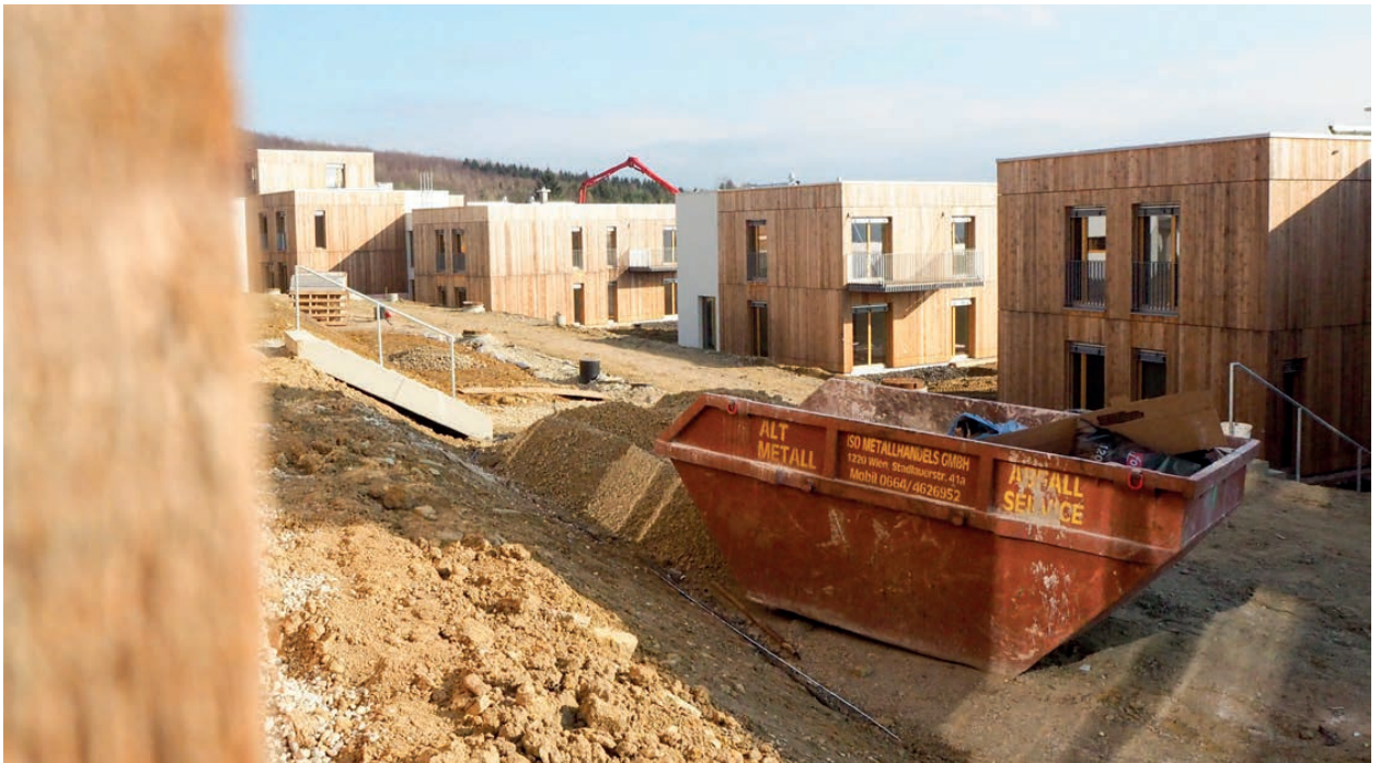
Endspurt auf der Baustelle B.R.O.T. Pressbaum – innen und außen laufen die finalen Fertigungsarbeiten.
