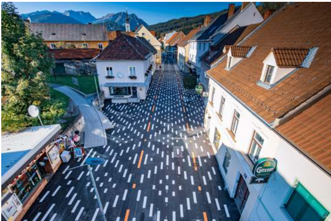
Neue Begegnungszone Trofaiach, Planung durch stingl-enge architekten ZT gmbh (c) Freisinger
