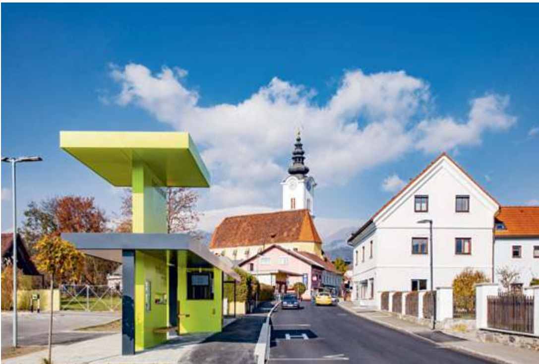
Neues Busterminal als Mobilitätsknoten in Trofaiach, Planung durch stingl-enge architekten ZT gmbh (c) Freisinger
